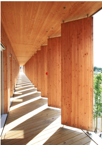
▲ Une façade bois en double épaisseur sous de généreux débords de toit
