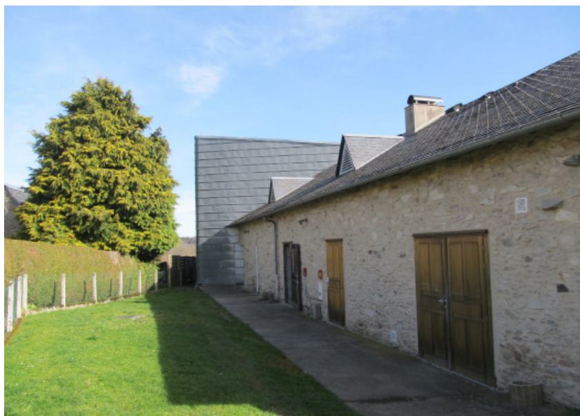
▲ Les abords, côté ouest
