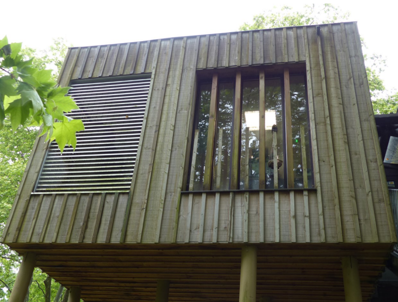
▲ Habillage en bois et brise-soleil
