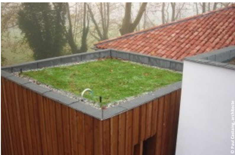
▲ Toiture de l'extension végétalisée
