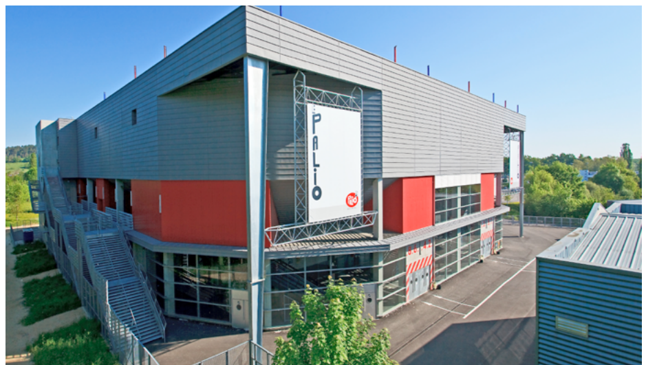
▲ L'architecture métallique avec son code couleur rouge confère au bâtiment une forte visibilité
