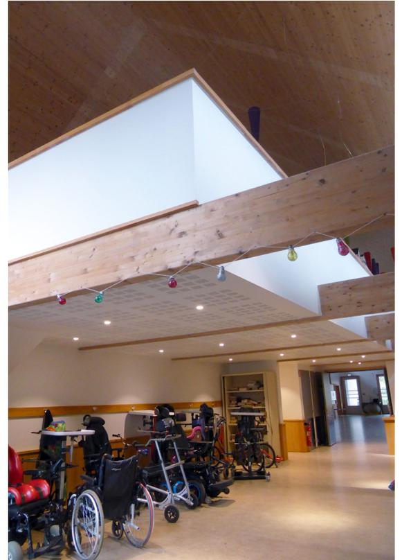
▲ La mezzanine repose sur la solide structure bois en lamellé-collé.
