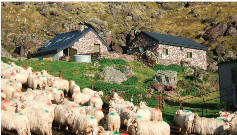
▲ La cabane de Caillabère à Borçe en Vallée d'Aspe. Ces constructions plus récentes dissocient le logement (à droite) et la fromagerie (à gauche).
