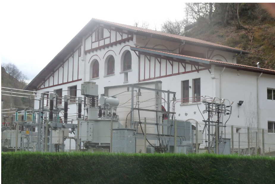
▲ Architecture néo-basque et transformateurs électriques
