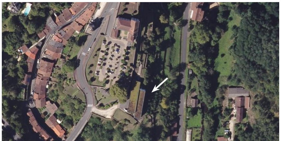
▲ Le bâtiment s'implante parallèlement à la pente, le long des anciennes terrasses
