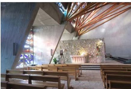
La charpente en bois (entreprise Cahours) laisse apparaître la sous face en lambris et les chevrons qui sont soutenus par des contrefiches disposées en parapluie.
