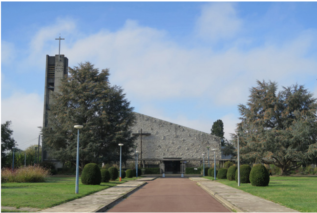
Une allée flanquée de cèdres met en scène l'arrivée sur le porche de l'église. La façade sur la place montre un mur aveugle bossagé, percée d'une simple porte avec une immense croix de bois.
