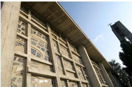
La façade sud est composée de voiles et de refends en béton, dont le quadrillage accueille un assemblage de dalles de verres éclatés colorés. Ces éléments vitrés ont été réalisés par le père Ephrem.
