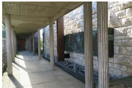
La galerie soutenue par des poteaux cannelés conduit au patio de la salle paroissiale, construite en 1979. Les maçonneries en béton sont réalisées par l'entreprise Albani.
