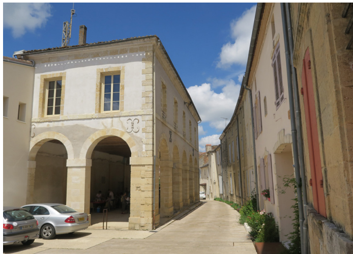
Après intervention. La halle au Chanvre, transformée dans les années 1960 en salle municipale, a retrouvé son caractère de halle ouverte grâce à la réouverture des arcades et au traitement du sol, un dallage continu d'une teinte uniforme.
