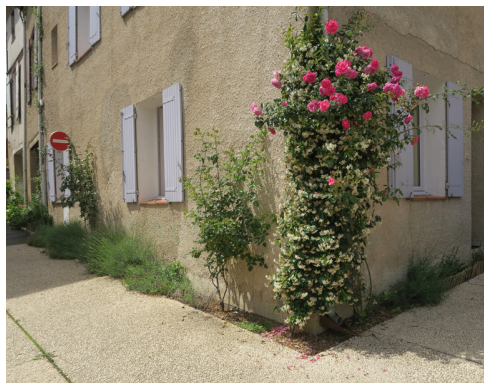
Une bande de terre végétale est créée en pied de façade afin que les habitants plantent fleurs et plantes grimpantes. Les pas de porte fleurissent, s'animent et incitent au cheminement piéton. Grille d'évacuation des eaux pluviales, collecteur de gouttière, mobilier urbain et emmarchement sont en acier corten.
