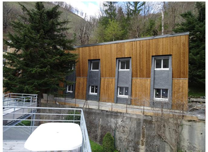
▲ Utilisation de l'ouvrage de soutènement existant comme socle de fondation.
