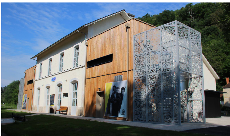
▲ Nouvel enduit sur le volume existant et extension bois et acier, en symétrie
