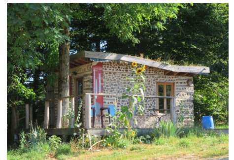
▲ De petites constructions expérimentales (toit végétalisé, bois-cordé, paille, etc...) sont le support des journées de formation aux techniques de l'éco-construction.
