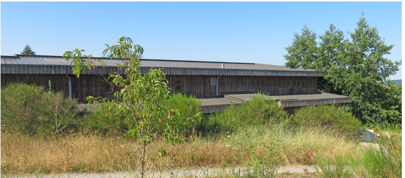
▲ Façade Nord du bâtiment
