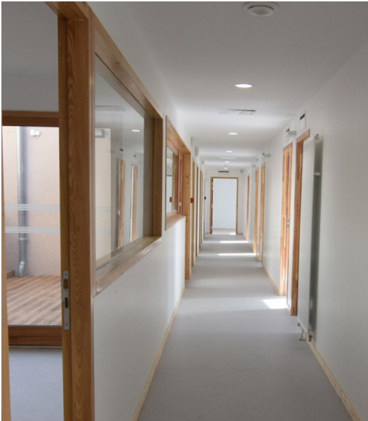
▲ Les encadrements de fenêtres se retrouvent dans l'aménagement intérieur. Un patio au Nord permet d'amener une lumière traversante.
