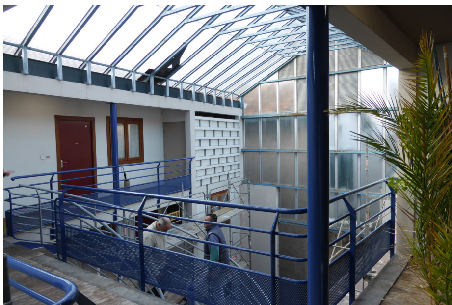
▲ La verrière et la façade pignon vitrée donnant sur la petite impasse d'accès.
