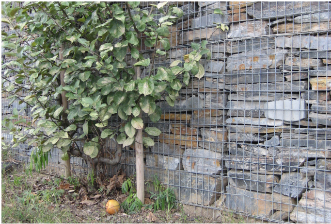
▲ Détail des gabions.
