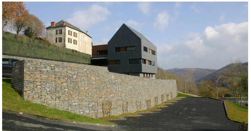
▲ Le soutènement monumental prolonge l'effet de rempart.
