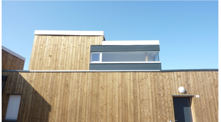
▲ Vue extérieure d'un pavillon
