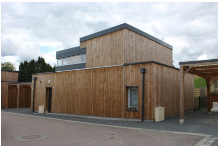
▲ Vue extérieure d'un pavillon
