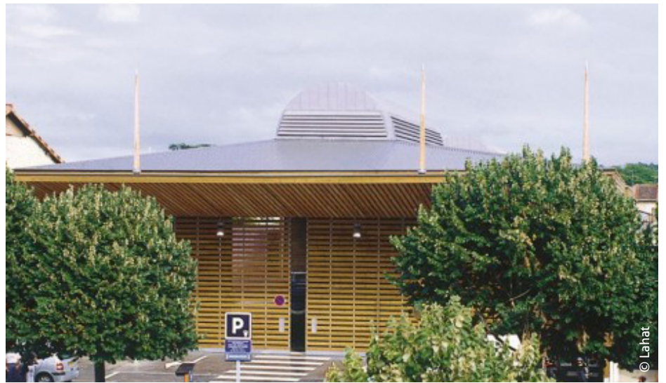
▲ La façade principale à la livraison
