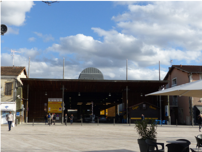
▲ La façade principale aujourd'hui
