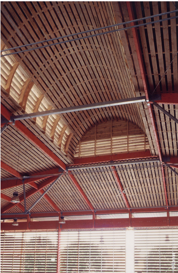
▲ Habillage intérieur en bois
