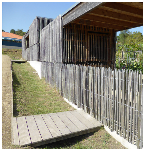
▲ Gestion des eaux pluviales par une noue au droit des potagers.
