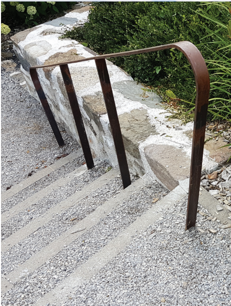
▲ Harmonie des matériaux
