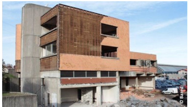
▲ Le centre de tri avant travaux
