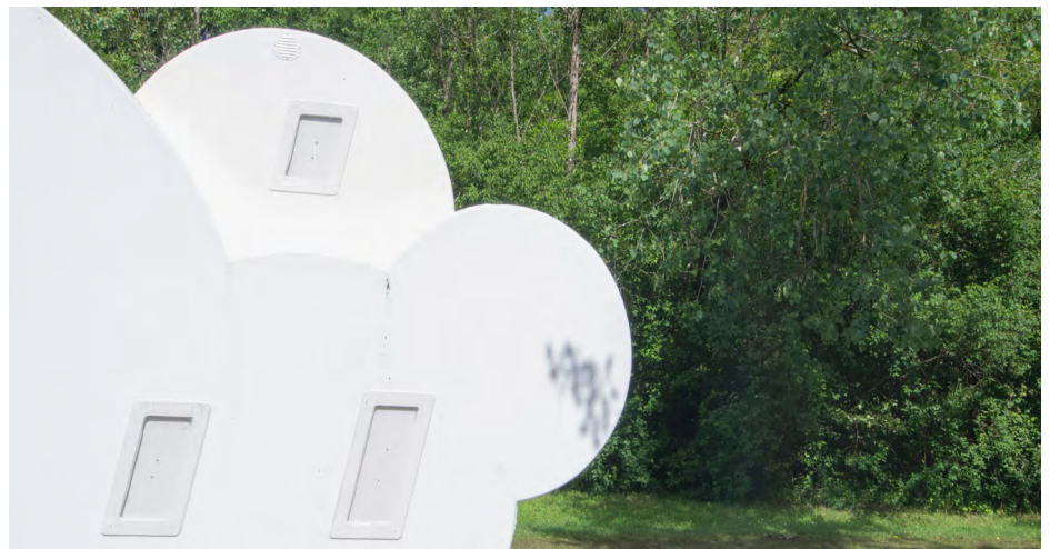
▲ De haut en bas : LA NUIT AMÉRICAINNE, Bassens Tertre de Panoramis, Fichtre 2015. Réalisation Zébra3/Buy-Sellf (8 couchages). Membrane bitumeuse et ossature bois LE NUAGE, Lormont Parc de l'Ermitage, Candice Pétrillo 2010. Réalisation Zébra3/Buy-Sellf (7 couchages). Ossature bois et acier
