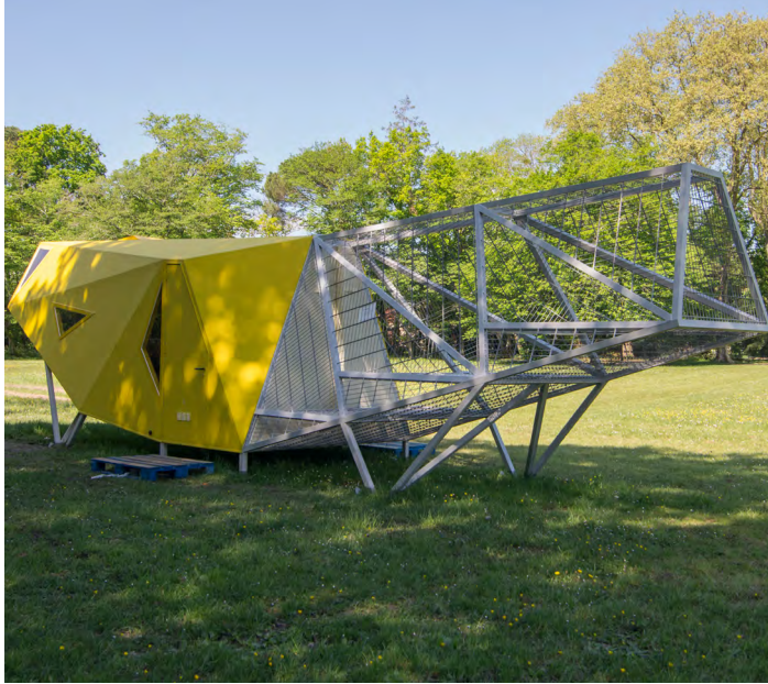
▲ LE HAMAC, Gradignan Parc de Mandavit, Yvan Detraz 2012. Réalisation Zébra3/Buy-Sellf (6 couchages). Structure acier
