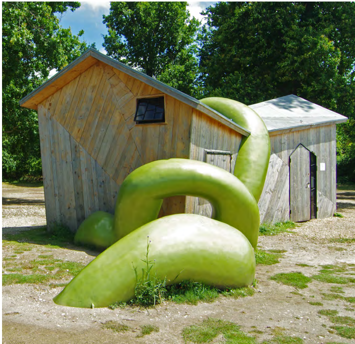
▲ LA VOUIVRE, Ambès Parc de Cantefrène, Candice Pétrillo 2013. Réalisation Zébra3/Buy-Sellf (7 couchages). Ossature acier, bardage bois et couverture en zinc
