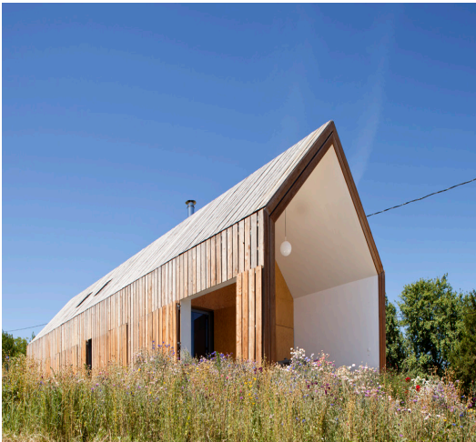
▲ Construction neuve, maison d'habitation à Nabirat, Coco architecture
