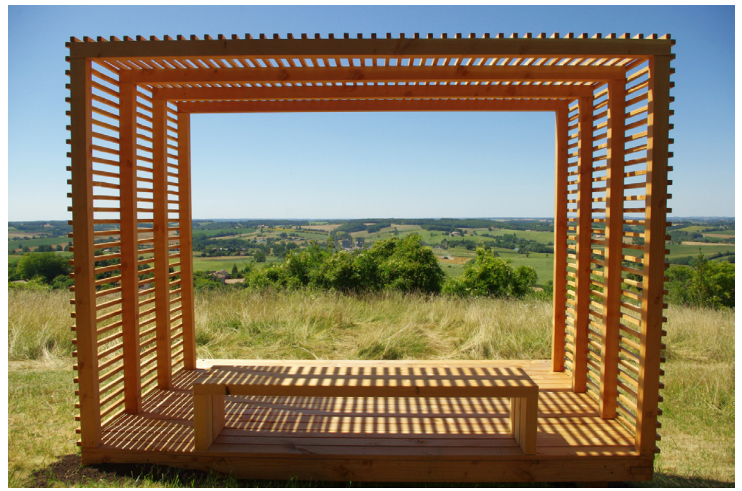
▲ Cette plateforme d'observation a été exécutée par Jean-Pierre Ruggeri, charpentier à Monbahus. Réalisée avec un matériau renouvelable (bois essence douglas), elle cadre une vue choisie et pourra, si nécessaire, être repositionnée ou recyclée, sans atteinte à l'environnement.
