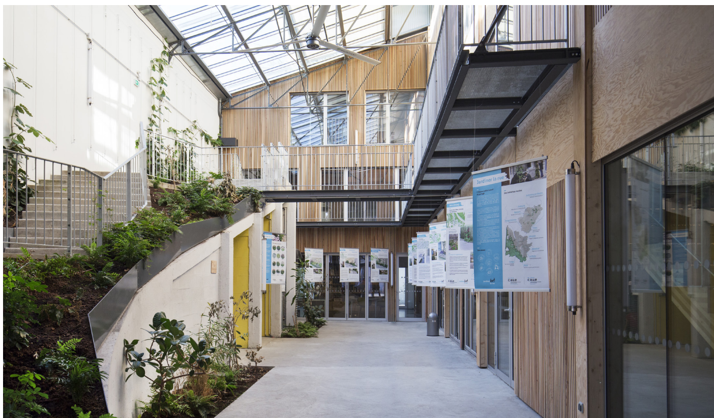
▲ Vue sur l'espace central de la serre, depuis la rue. A gauche, on voit la rampe végétalisée.
