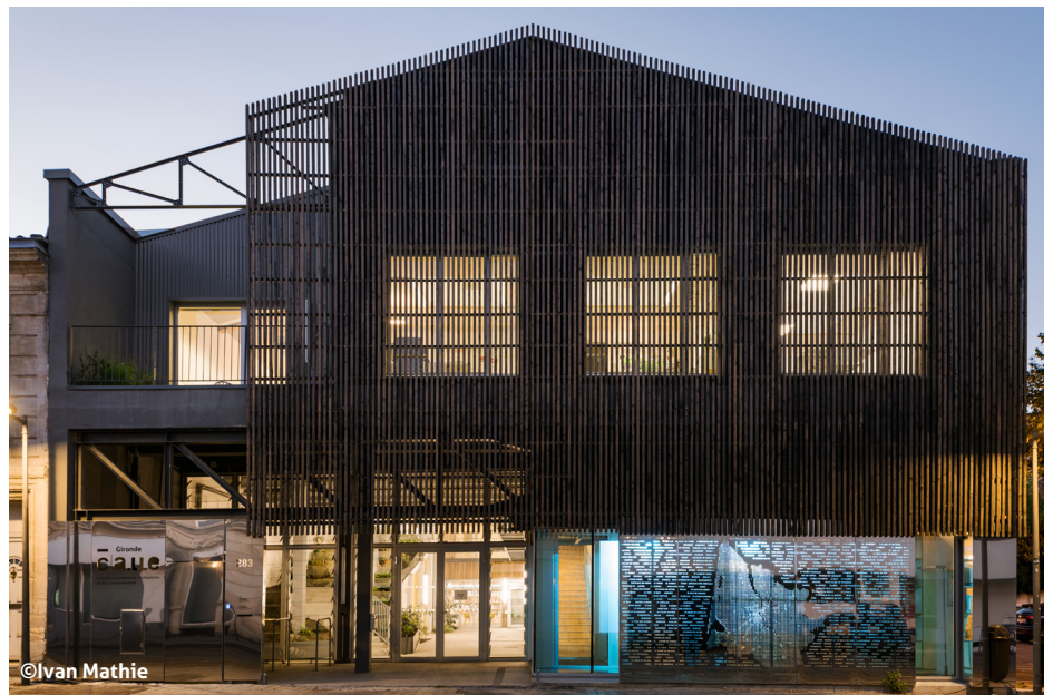
▲ En haut, détail d'un escalier, les matériaux sont laissés bruts. Ci-dessus : vue de la façade d'entrée sur la rue.
