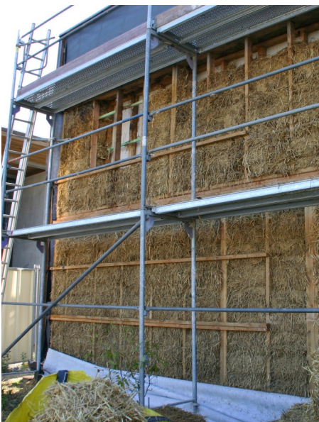
▲ Vue sur l'isolation en paille
