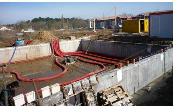
▲ Le réseau de gaines « hypocauste »
