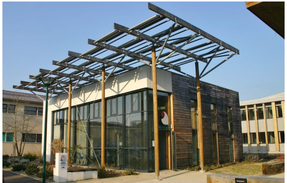
▲ Vue sur les façades Sud et Est
