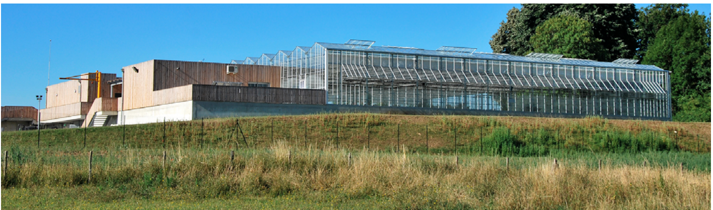
▲ La sobriété des lignes facilite l'intégration dans ce paysage naturel, tout en faisant oublier sa vocation première
