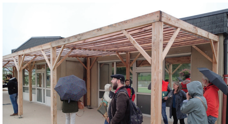
▲ Pergolas réalisées par l'ADAPEI
