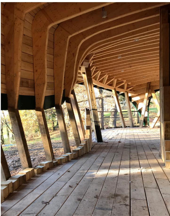
▲ Pour ses réalisations complexes l'architecte s'appuie sur la modélisation informatique puis c'est en atelier qu'il réalise les tracés et les découpes des tranches de bois galbées dans des panneaux de bois issus des forêts locales. La charpente est ensuite intégralement assemblée à la main.
