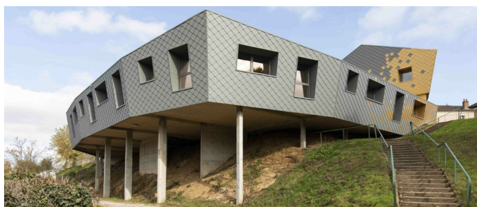
▲ Vue extérieure façades sur pilotis
