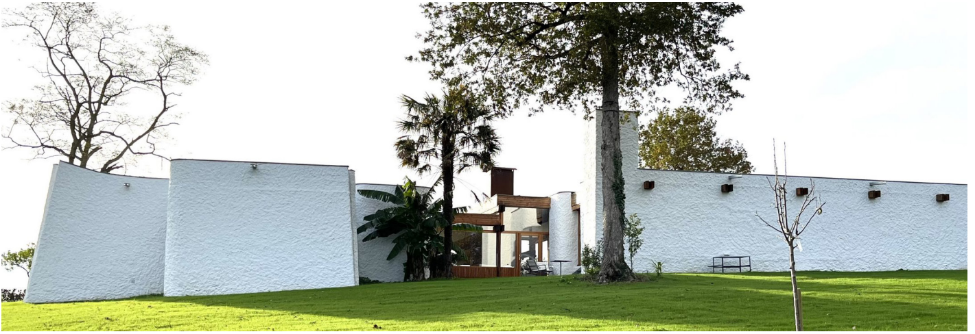
▲ Façade Nord-Est, murs pleins de béton crépis blanc qui contrastent avec la transparence du vitrage central et les fines ouvertures que l'on devine dans les angles des différents volumes
