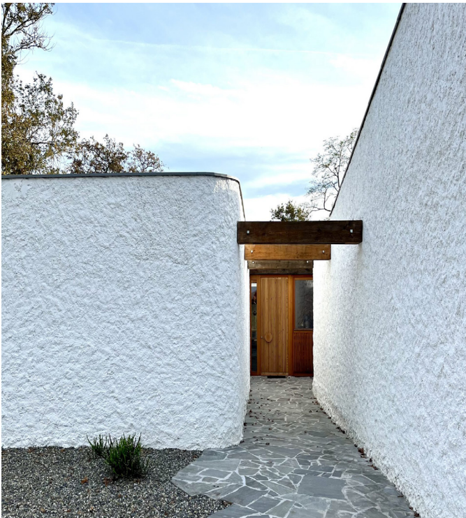
▲ Le rapprochement des deux volumes invite à rejoindre l'entrée
